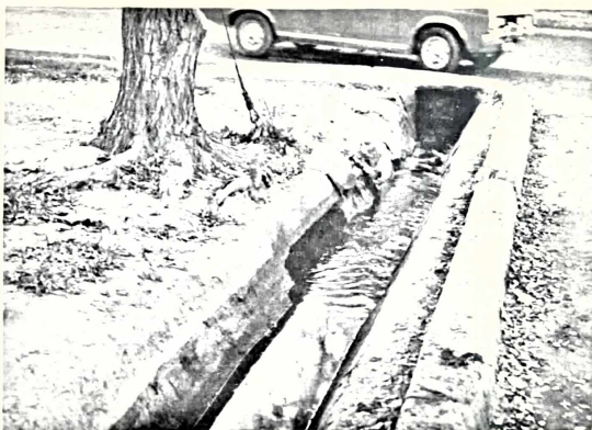
Fot. 8 — Acequia de la esquina de Perú y Coronel Plaza, con la boca de salida de un canal de desagüe residual.
