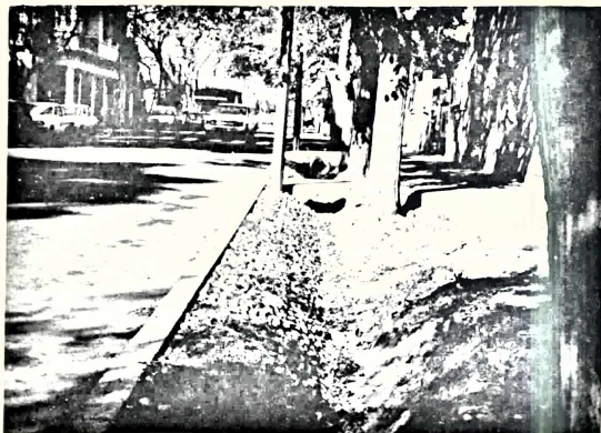
Fot. 7 — Típica acequia mendocina, recubierta de cantos rodados, en calle Perú, sistema que favorece el riego del arbolado público.
