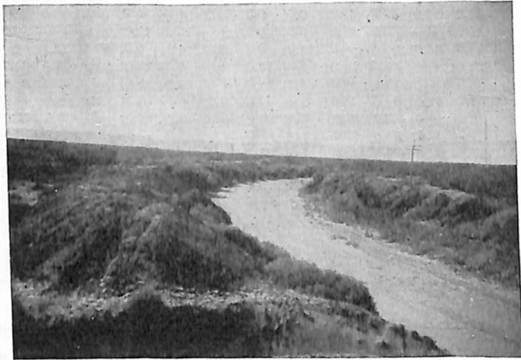
El mismo cauce tomado desde el terraplén de la vía férrea, muestra su amplio lecho y sus elevadas barrancas en ambas orillas.
