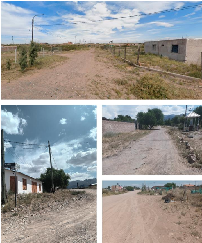
Figura 20: Infraestructura vial vulnerable.
