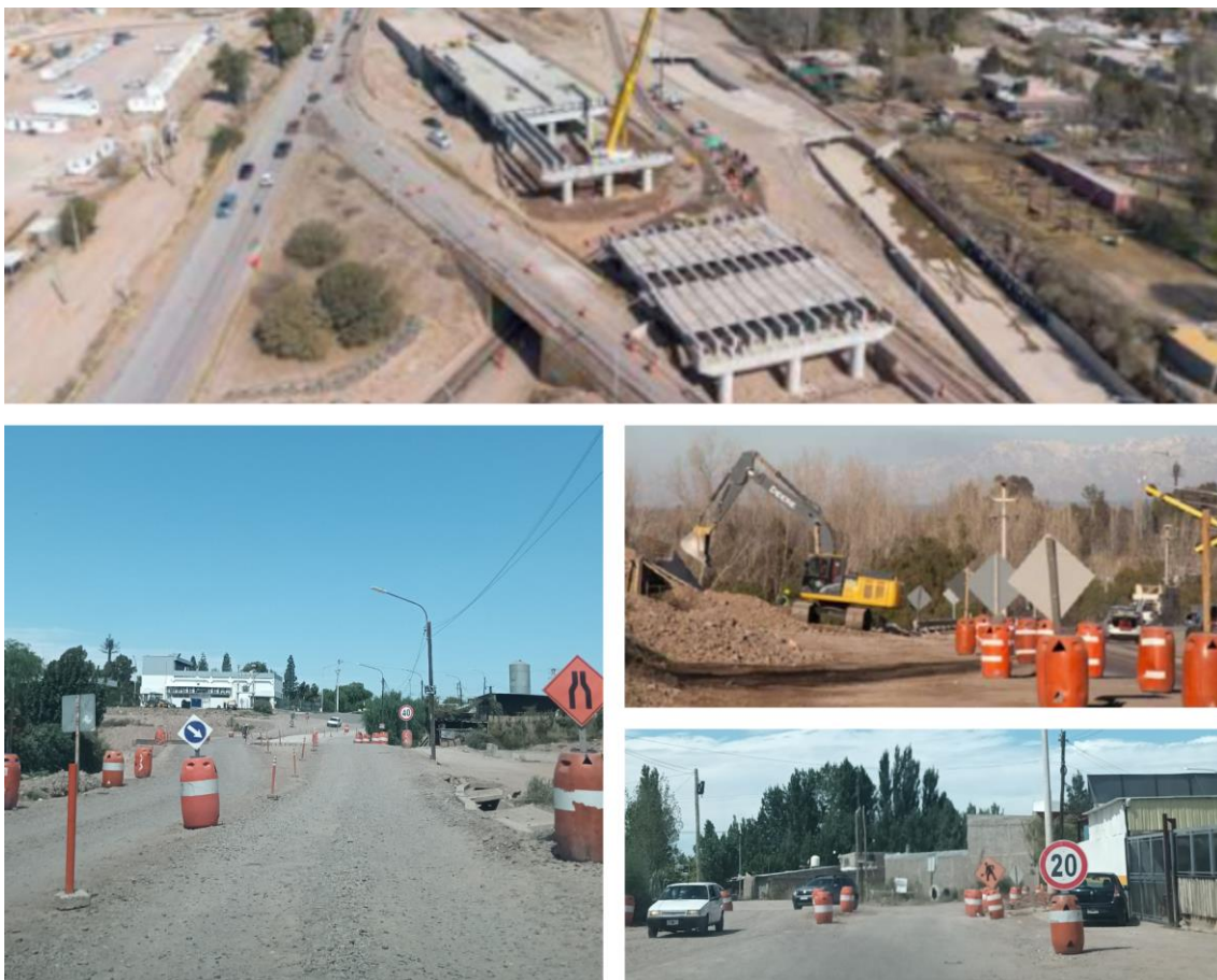
Figura 11: Obras en Ruta Provincial n° 82.
