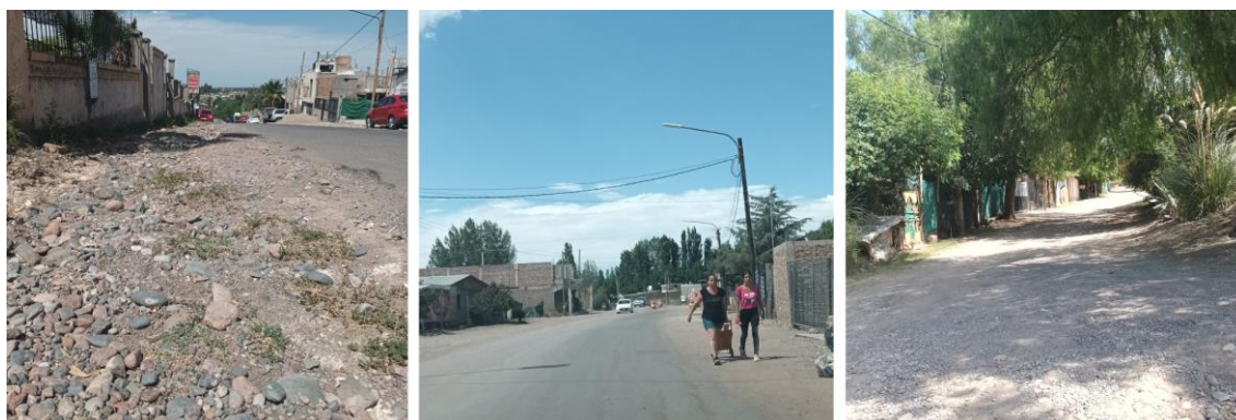
Figura 14: Fotografía de las condiciones de los costados de las calles | Ausencias de veredas.
