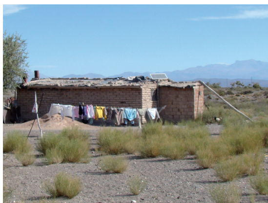
Aprovechamiento de energía solar en un puesto en el campo malargüino.
